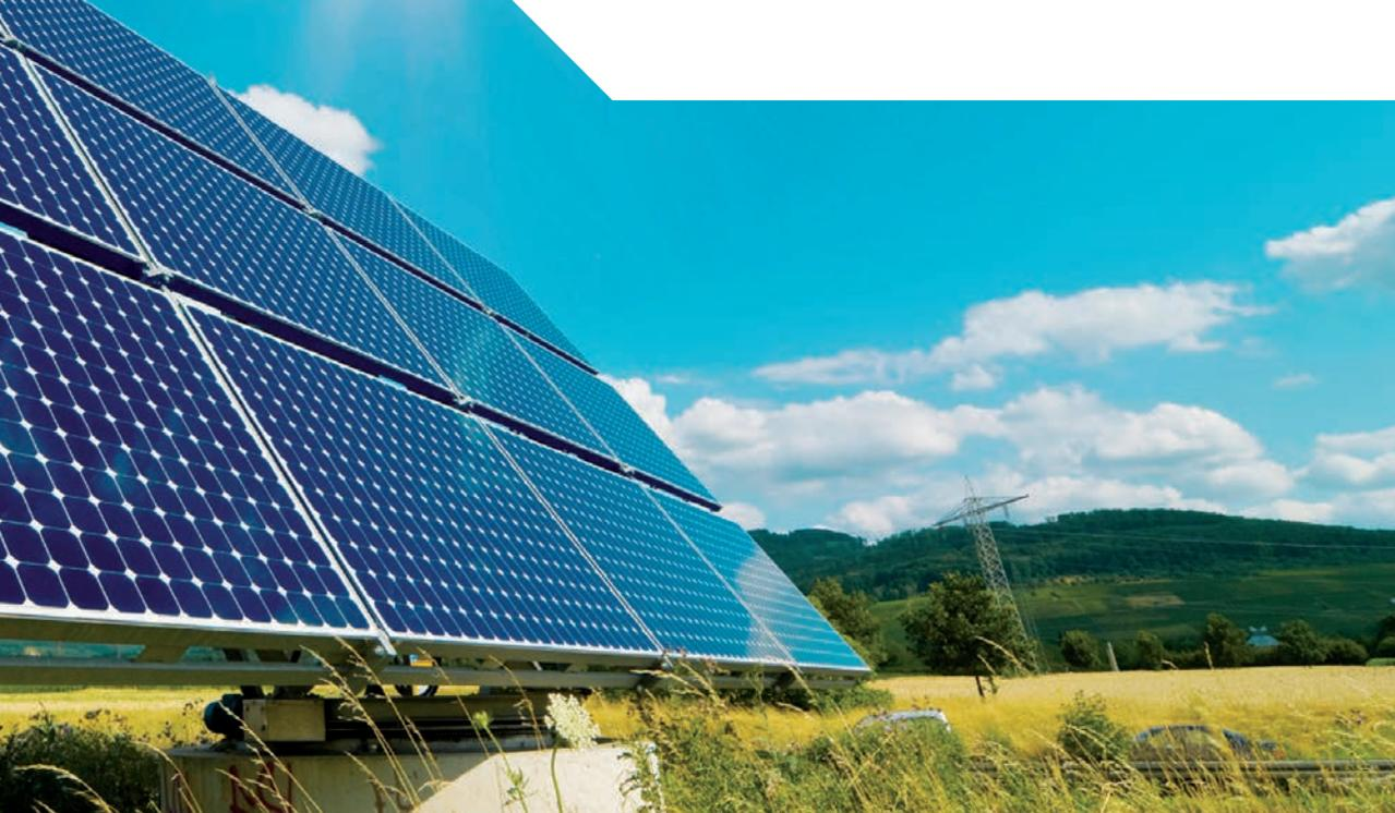
La tecnologia fotovoltaica consente di trasformare direttamente la luce solare in energia elettrica. Sfrutta il cosiddetto effetto fotovoltaico di alcuni materiali semiconduttori, come il silicio, in grado di generare elettricità se colpiti dalla radiazione solare.
